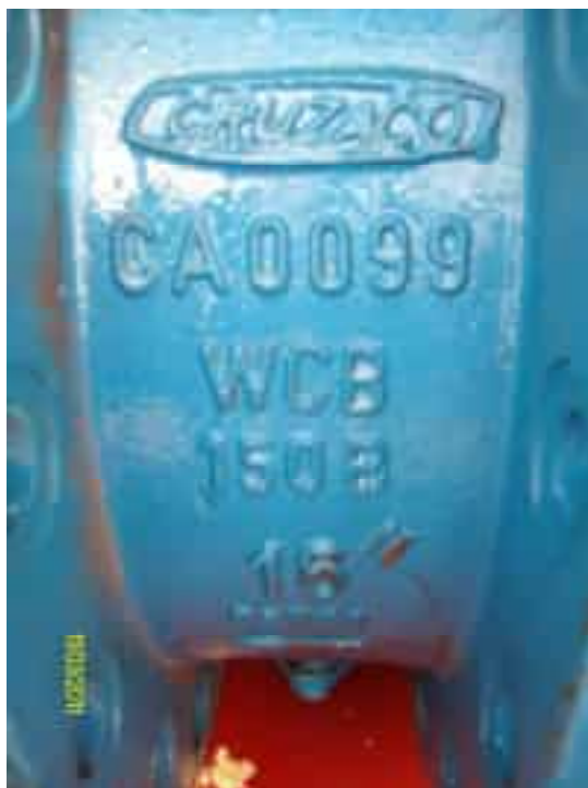
Válvula Borboleta: WCB - identificação do tipo de corpo; 150B - classe de pressão 150 libras; 16" - diâmetro nominal expresso em polegadas (DN 400 mm)
