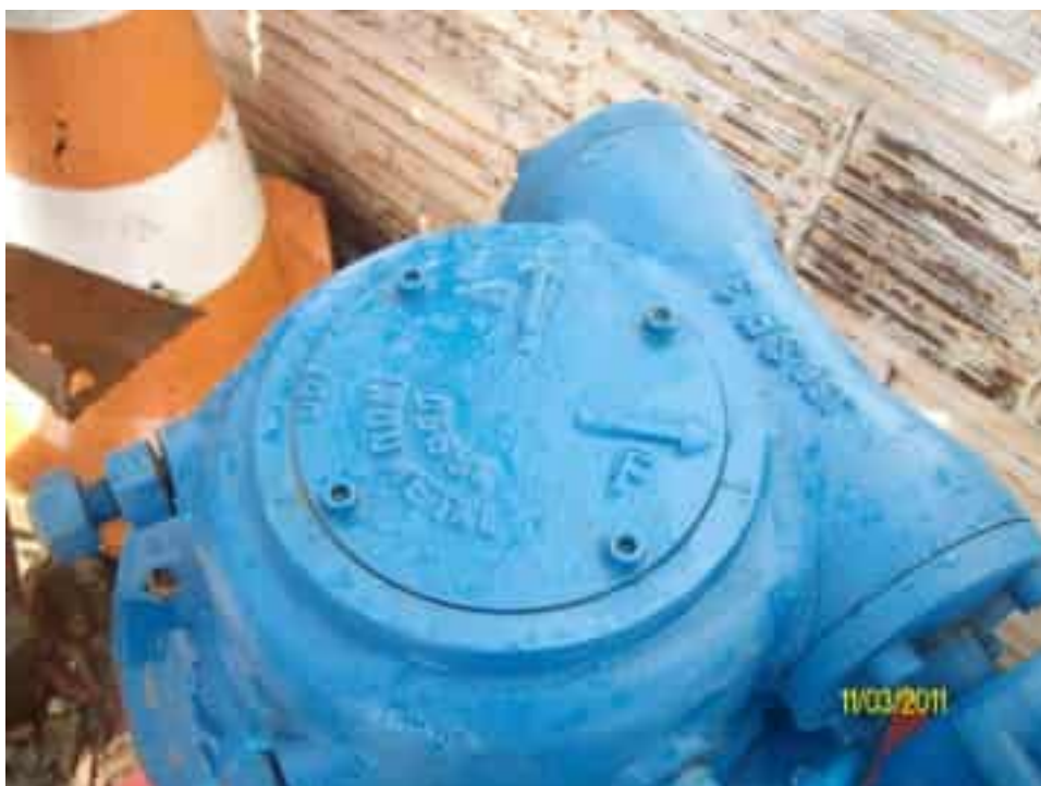
Válvula Borboleta: sistema de redutor de engrenagens com indicador de abertura do obturador
